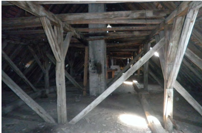
Južno krilo- krovište, pogled prema istoku
