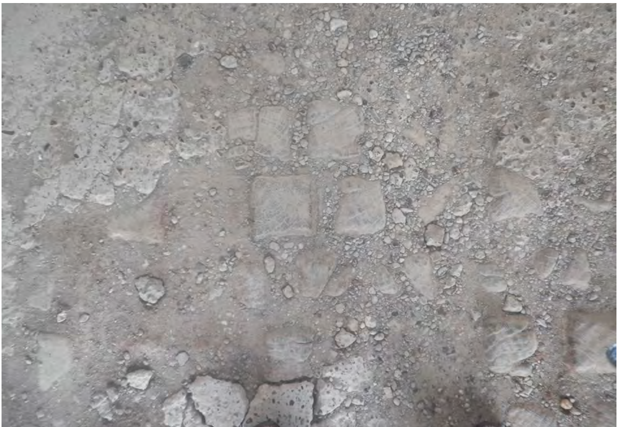
Kolni prolaz 17 - tragovi izvornog popločenja drvenim kockama
