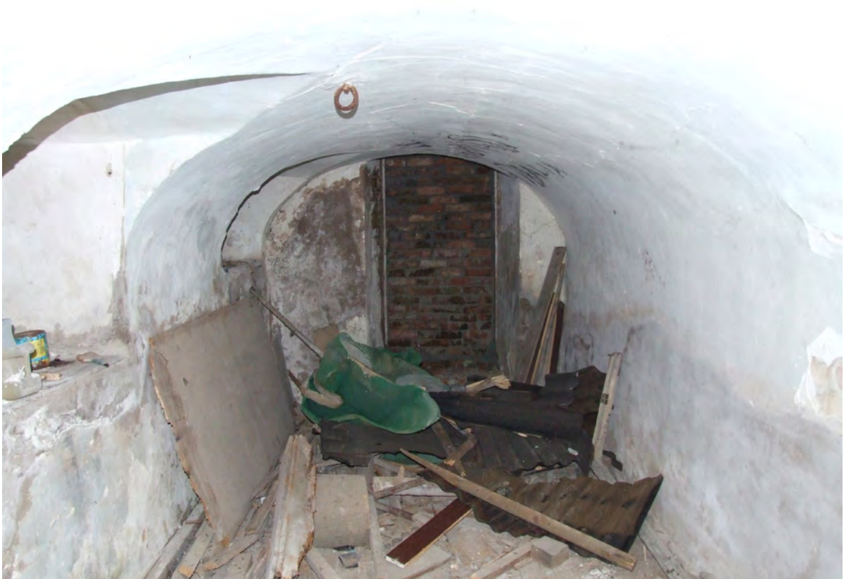
Prostorija II - pogled prema istoku, recentno zazidani otvor
