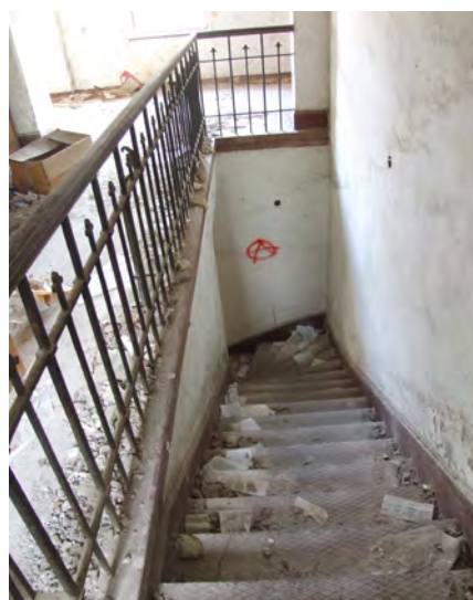
Stubište 4I - stubišni krak
