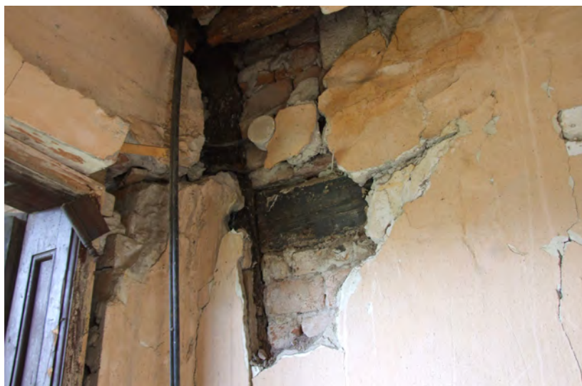
Prostorija 69 - detalj kanatne konstrukcije
