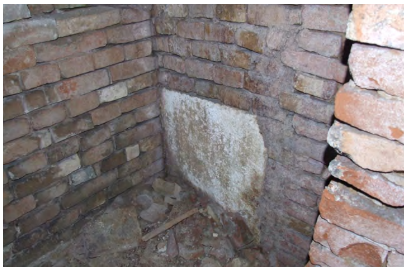
Podrum Z - kamena spolija u dokinutom stubištu na zapadu
