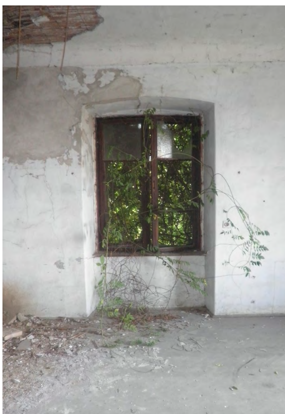
Prostorija 39 - prozor na južnom zidu
