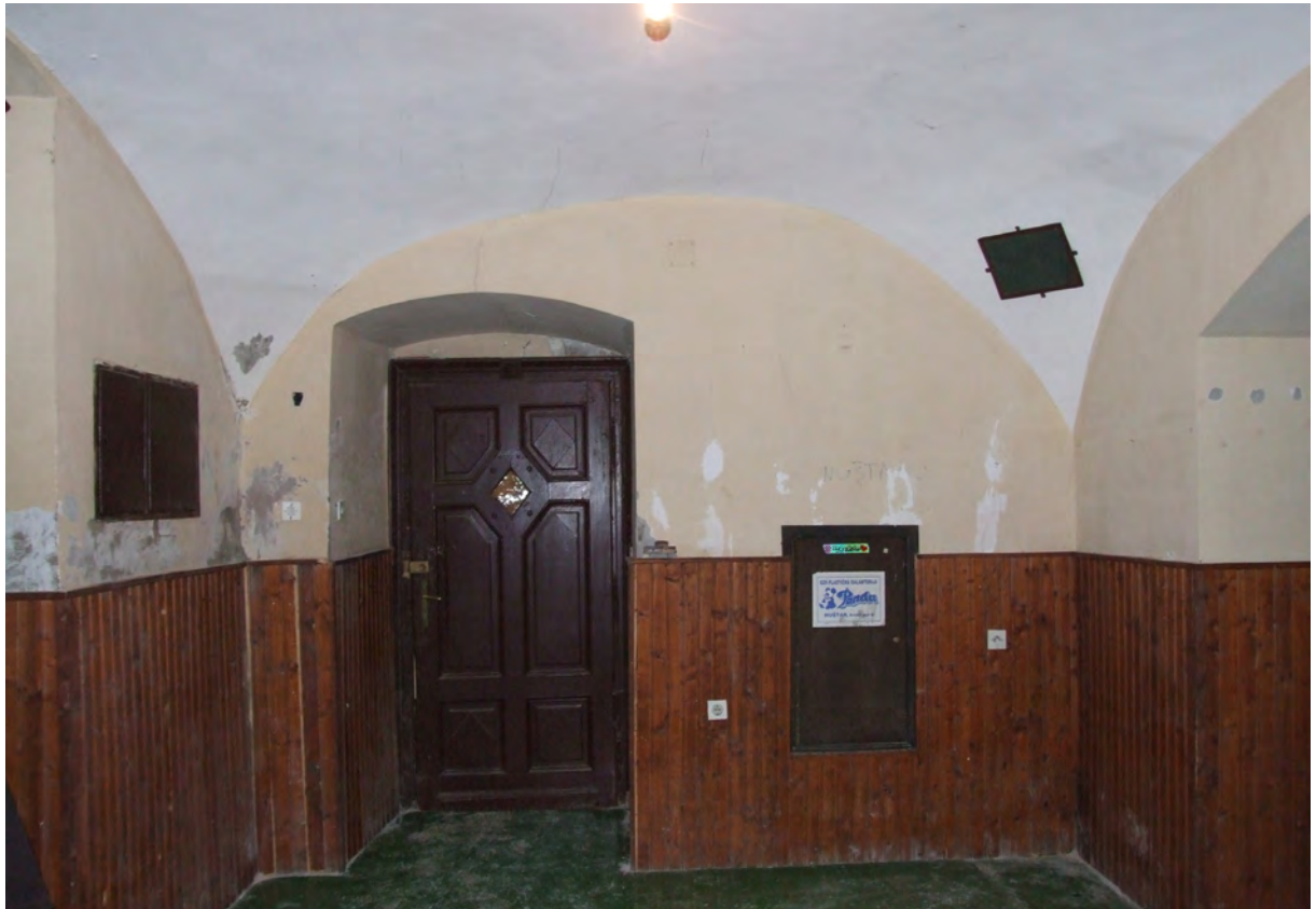
Prostorija 16 - pogled prema sjeveru i ulaznim vratima
