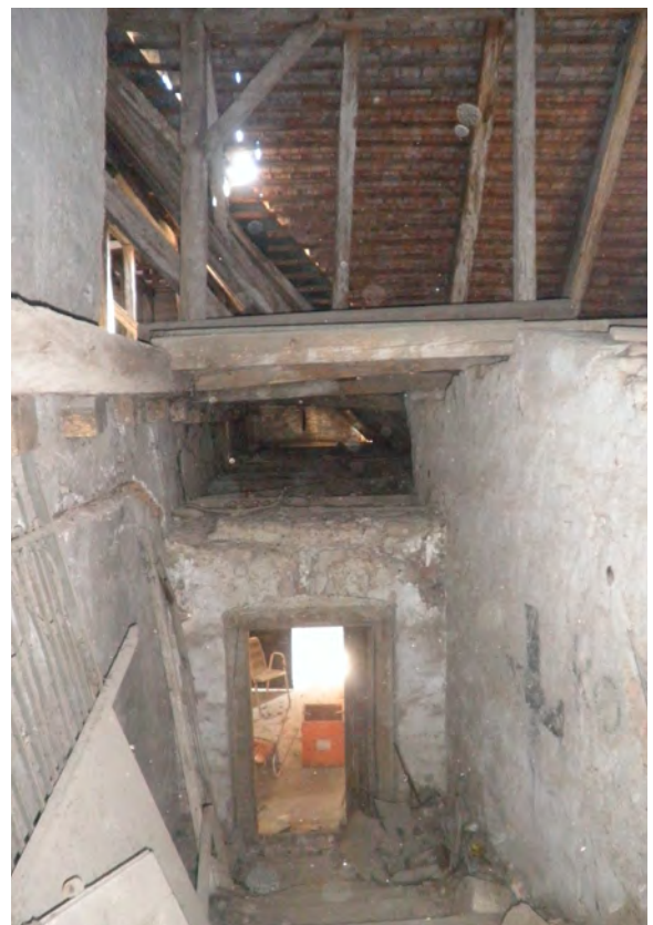
Zapadno krilo- krovšte, pogled prema ulazu (trijem 49)
