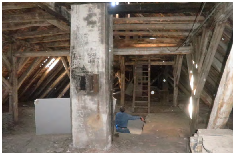
Južno krilo- krovište, pogled prema istoku
