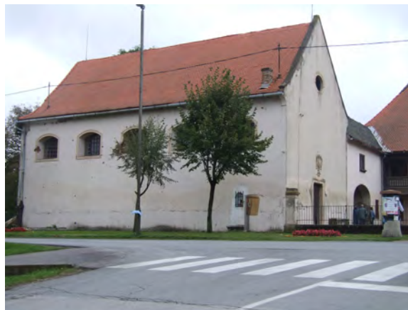
Sjeverno pročelje crkve
