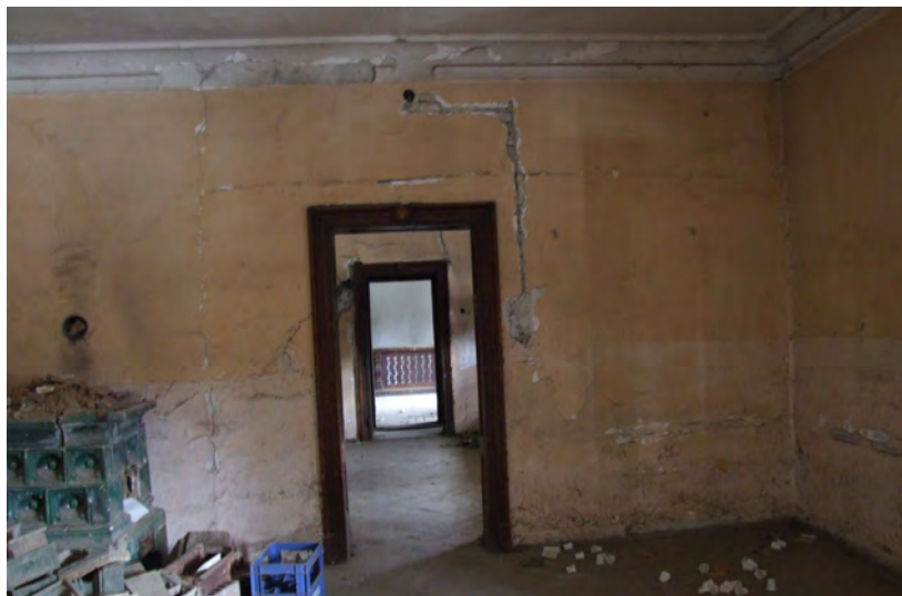
Prostorija 56 - pogled prema istoku i stubištu
