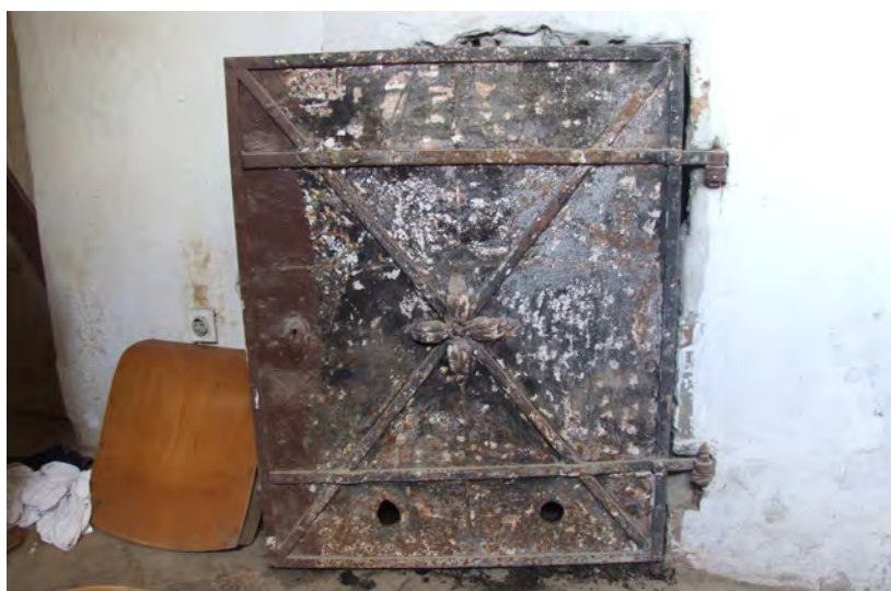
Trijem 6 - vrata ložišta
