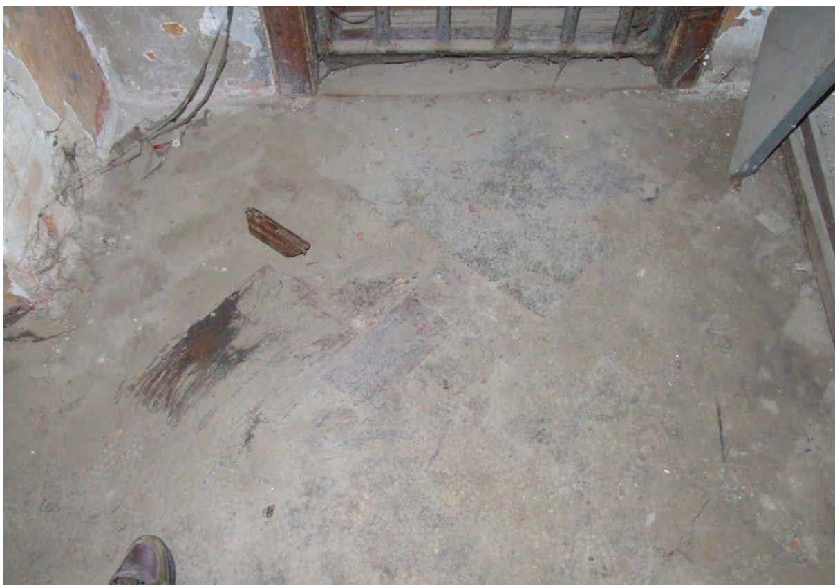
Trijem 6 - tragovi izvornog popločenja opekom
