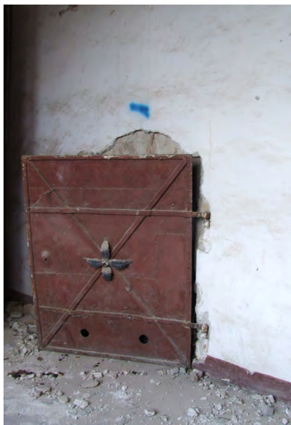
Trijem 42 - vrata ložišta
