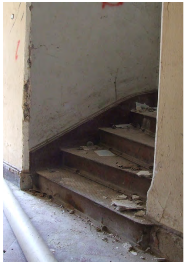
Stubište 5 - stubišni krak
