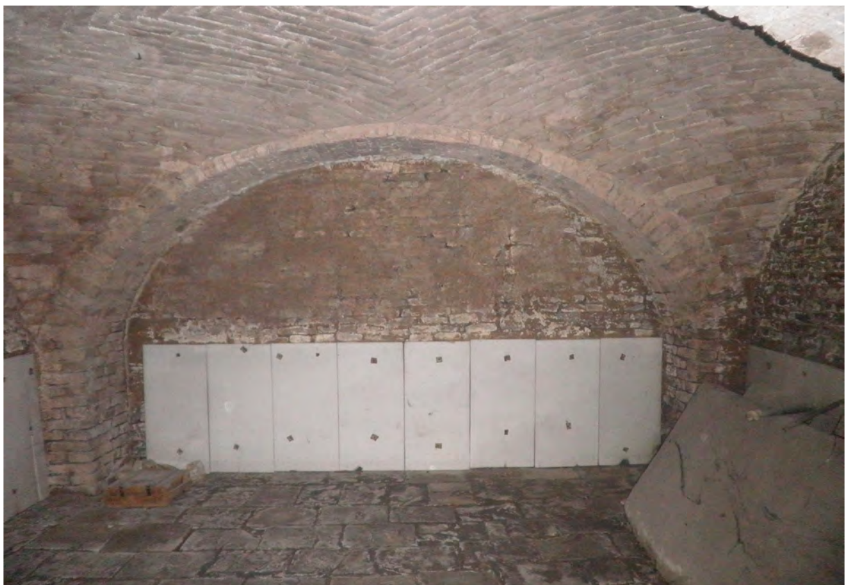
Podrum J - zapadni zid
