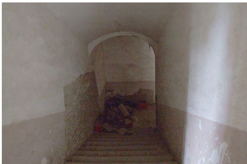
Stubište 48 - pogled s kata na podest
