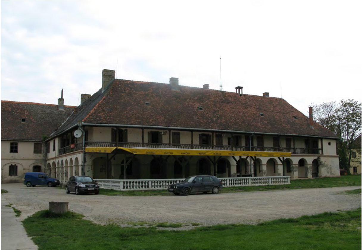
Južno pročelje južnog krila
