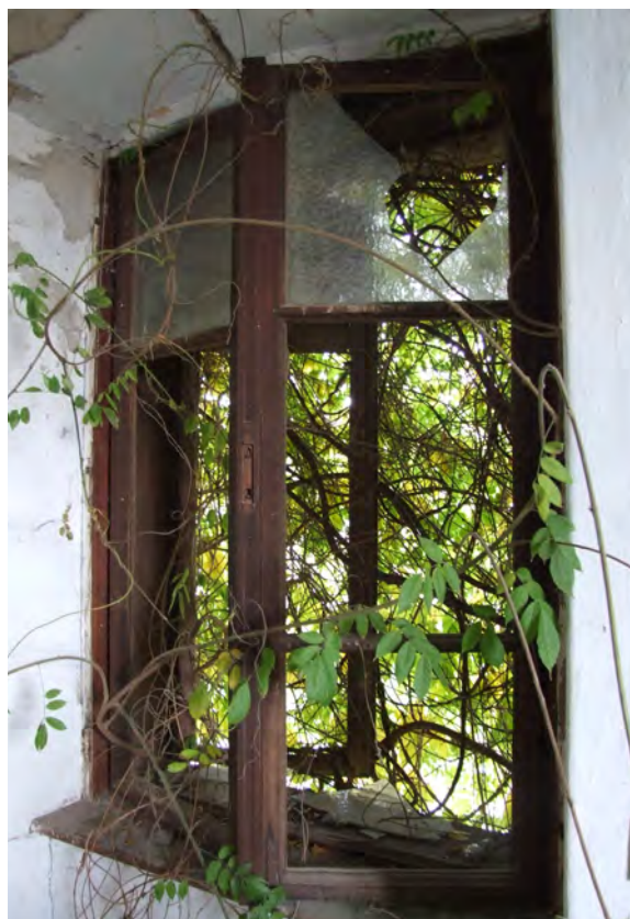
Prostorija 39 - prozor na južnom zidu
