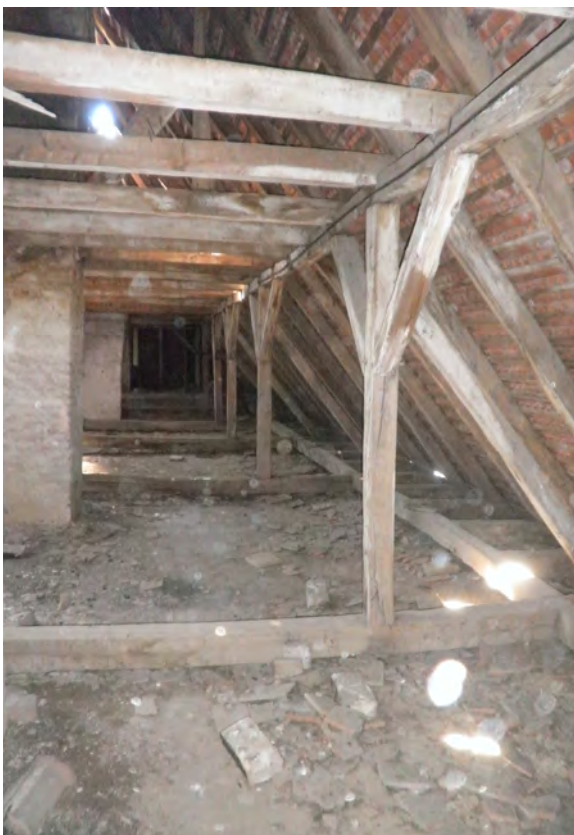
Zapadno krilo- krovšte, pogled prema zapadu
