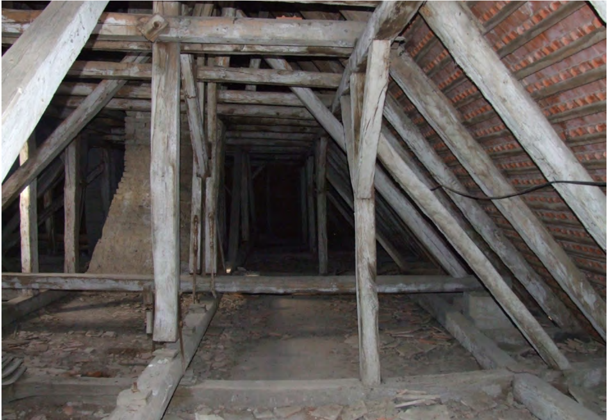
Zapadno krilo- krovište, istočni dio, pogled prema sjeveru
