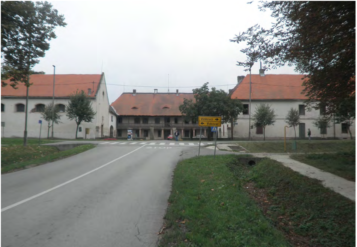
Sjeverno pročelje kompleksa
