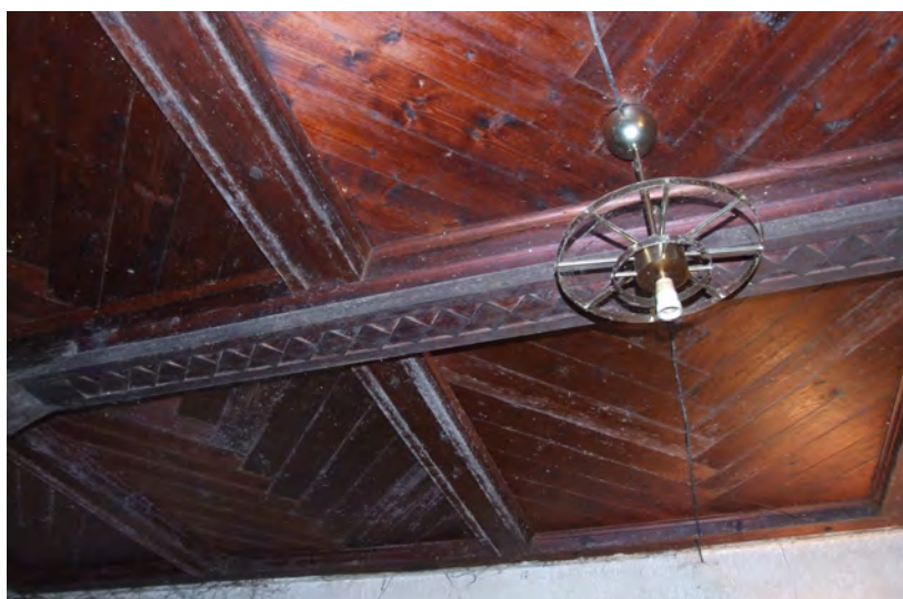
Prostorija 29 - drvena oplata stropa
