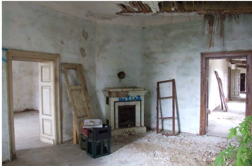
Prostorija 39 - sjeveroistočni ugao i kamin
