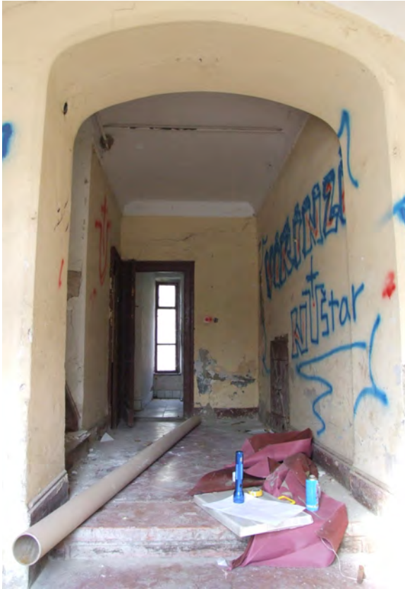
Stubište 5 - pogled prema sjeveru
