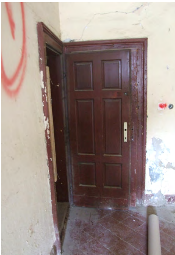
Stubište 5 - vrata prostorije 3
