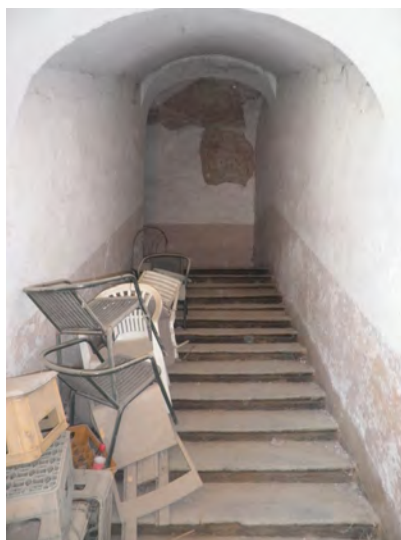
Stubište 48 - pogled iz prizemlja prema podestu
