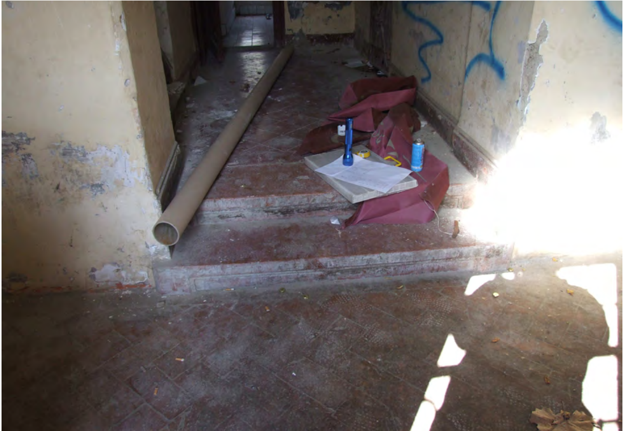
Stubište 5 - detalj popločenja
