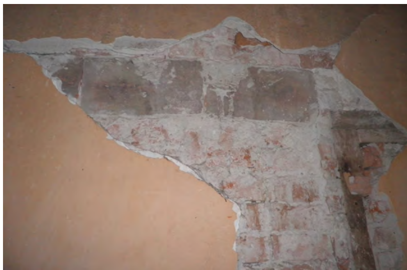
Prostorija 55 - detalj kanatne konstrukcije
