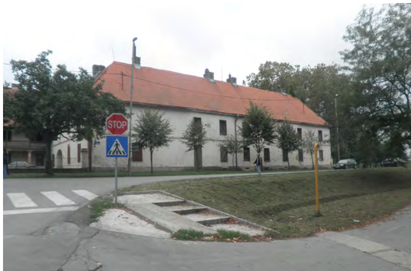
Sjeverno pročelje zapadnog krila
