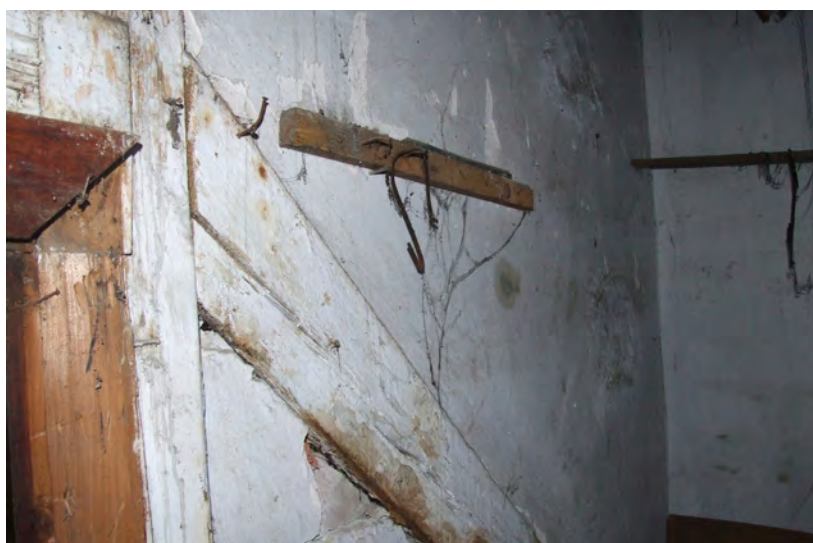
Prostorija 65 - detalj kanatne konstrukcije
